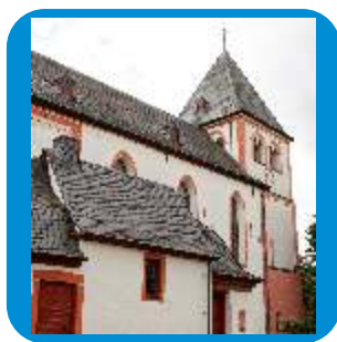
Sankt Petrus, Lüftelberg Petrusstraße
